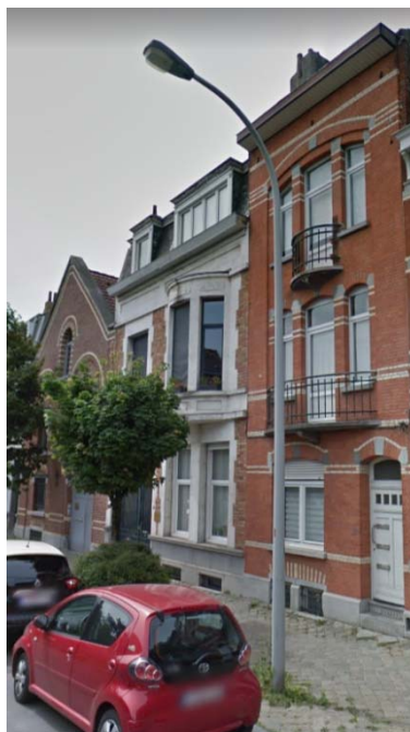
Avenue du Bempt
