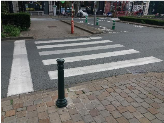
Figuur 5: voetgangersoversteekplaats en voor verbetering vatbare trottoirverharding op het Albertplein - bron: Traject
